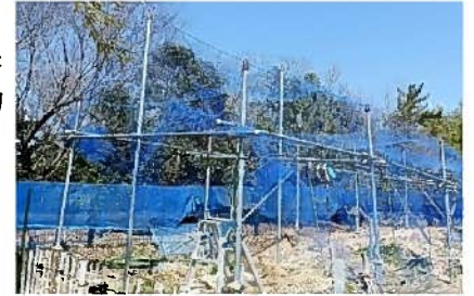
中間支柱及び補強筋交い新設
